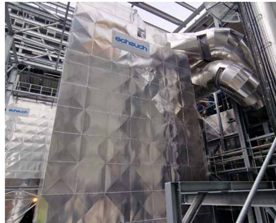
Die Abgasreinigungsanlage von Scheuch reduziert Emissionen und spart Energie.
