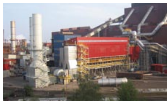
Kammerfilter in der Stahlindustrie
