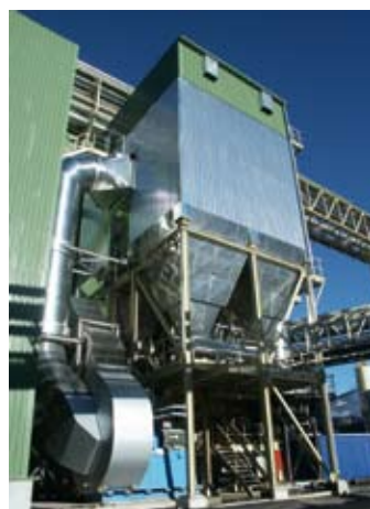
Камерный фильтр для очистки дымовых газов
