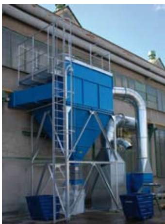
Резервуарный фильтр для пескоструйной очистки
