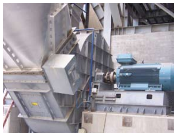
Beidseitig gelagerter Prozessventilator
