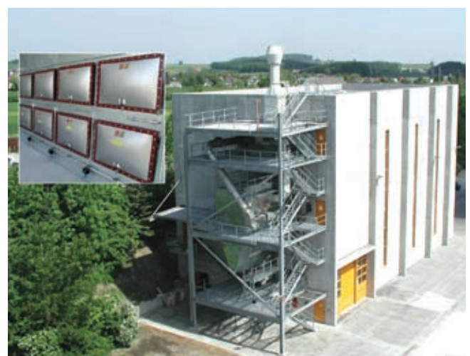
Scheuch IMPULS-Filter mit acht Berstscheiben in Außen-aufstellung vor der Halle
